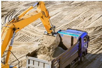
Matériau de construction
